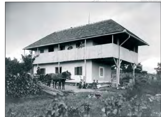
Vinogradarska kuća Ladislava Kraljevića u Dragi
